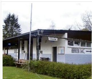
Muss langfristig saniert werden: Das Hauptgebäude im Wasserpark.
